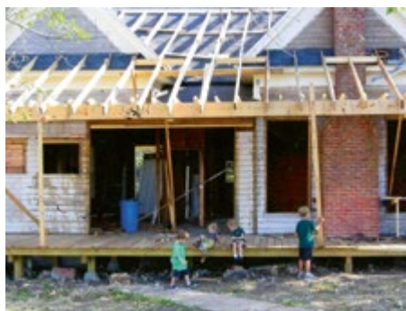
DAS FARMHAUS WÄHREND DER RENOVIERUNGEN.
